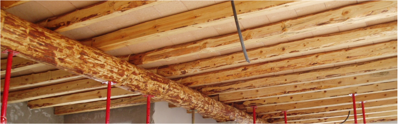
Ejemplo de techo de madera rustico en construcción nueva.
