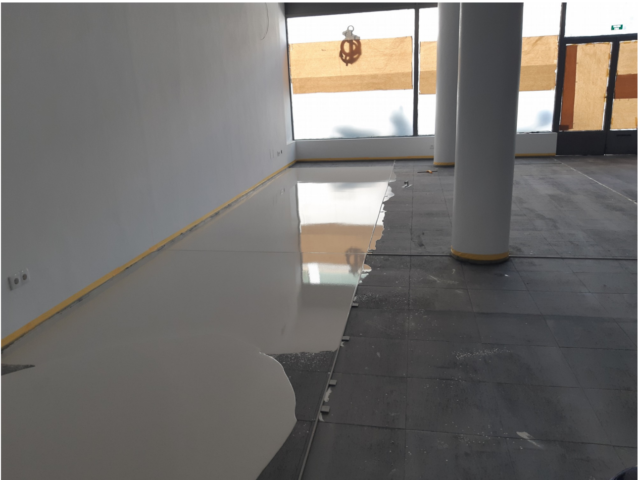
Aplicando autonivelante en color blanco
