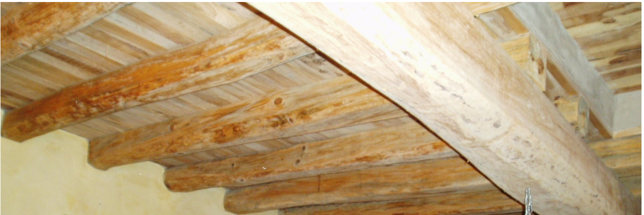
Ejemplos techo de madera rustico en rehabilitación casa antigua.
